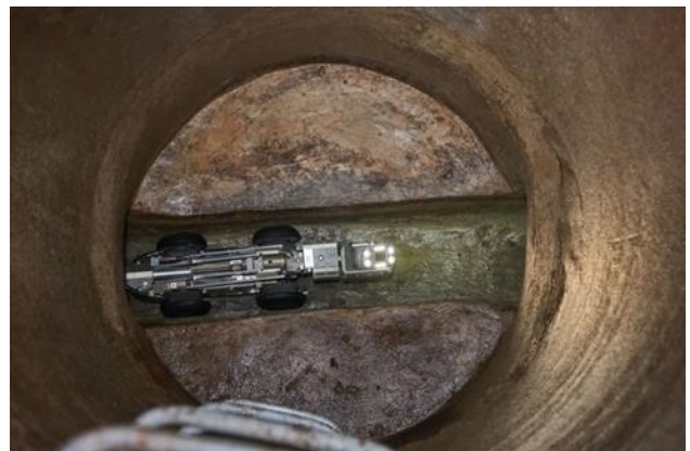
Einsatz im Kontrollschacht / Beginn Untersuchung
